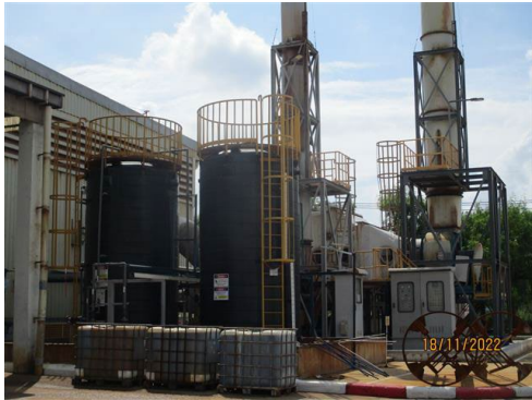
ภาพที่ 2-23 ถังรวบรวมกรดเกลือเสื่อมสภาพ
