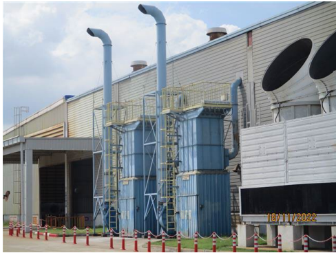
ภาพที่ 2-1 ระบบรวบรวมและดักฝุ่นแบบลูกกรง
