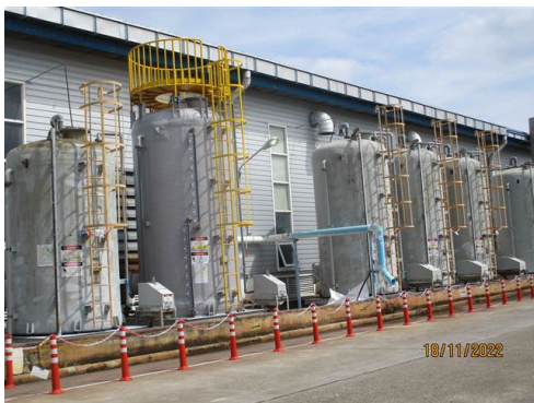
ภาพที่ 2-25 ถังรวบรวมกรดกำมะถันเสื่อมสภาพ
